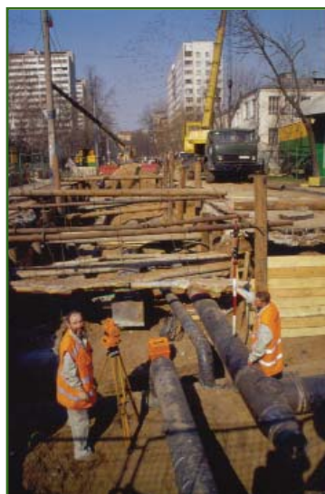
Рис. 1 Исполнительная съемка подземных коммуникаций
